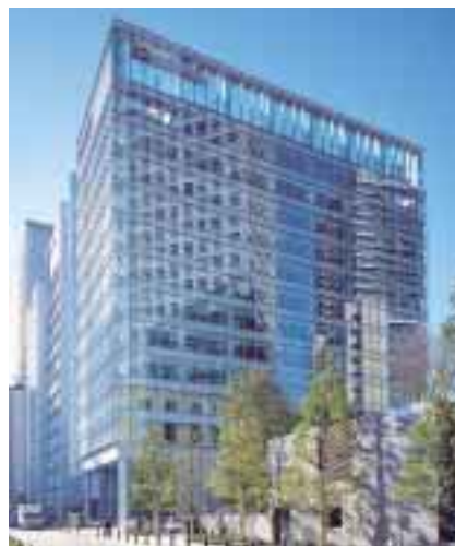
大塚商会 新本社ビル
